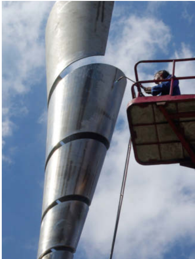
Flammrichten: 14 m hohes gestrecktes Hyperboloid in Siegen
